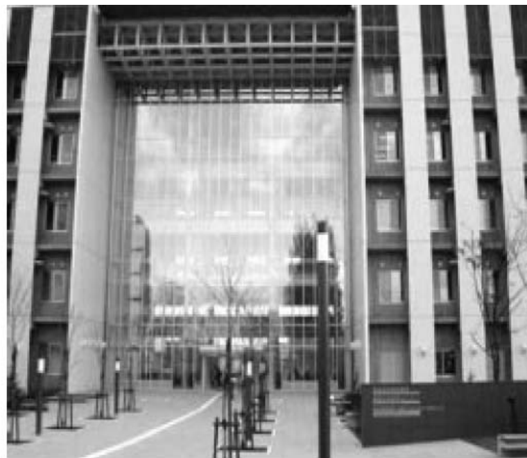
図2 酸化チタンコーティングガラス 北海道大学創成科学研究棟の西面のガラスは酸化チタンコーティングされている。可視光・赤外線カットにも効果がある
